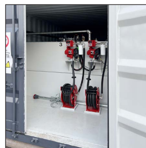
Pumpar med filter och slangvindor.
